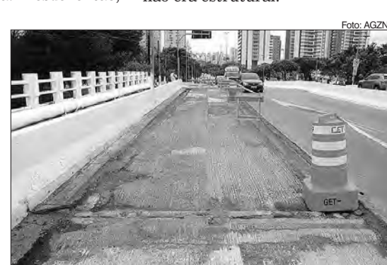
Ponte do Limão é interditada para obras
