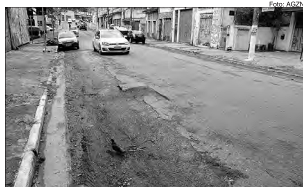
Avenida Casa Verde recebe obras de recapeamento
