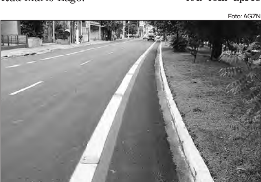
Avenida Engenheiro Caetano Álvares foi contemplada no Programa Asfalto Novo
