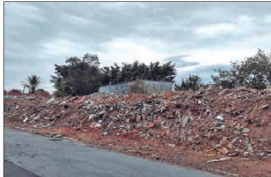
No mesmo local, o entulho já foi retirado e as obras estão em andamento para impedir o descarte irregular de lixo e entulho
