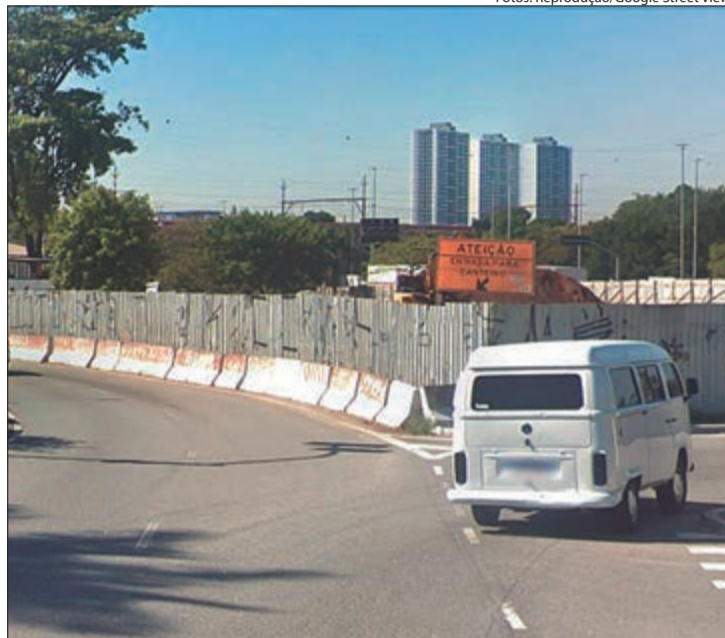
Canteiro de obra na alça de acesso na Marginal Tietê e a partir de julho a Avenida Raimundo Pereira de Magalhães será alargada
