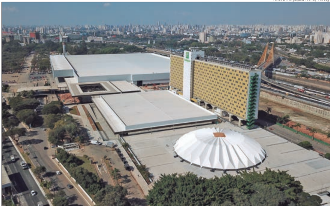
Imagem aérea no Anhembi, que teve características preservada mas estrutura toda modernizada
