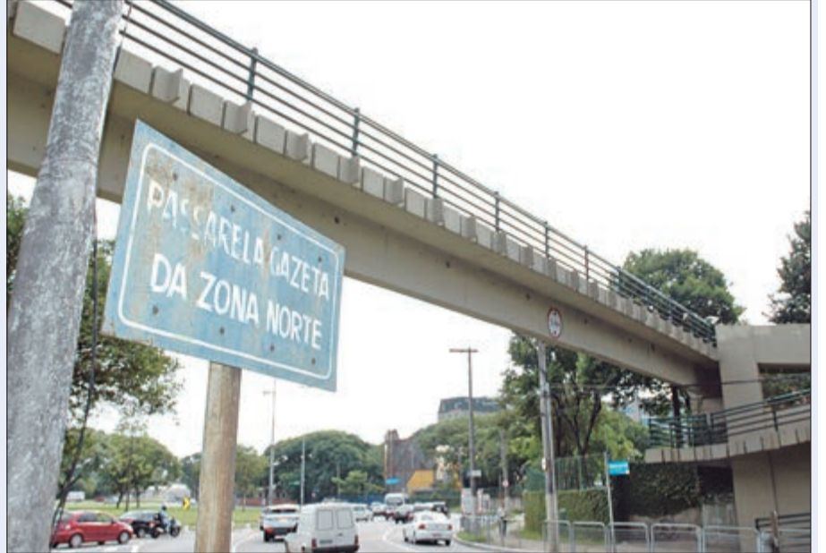
Obras na Passarela A Gazeta da Zona Norte devem ser concluídas ainda neste mês
