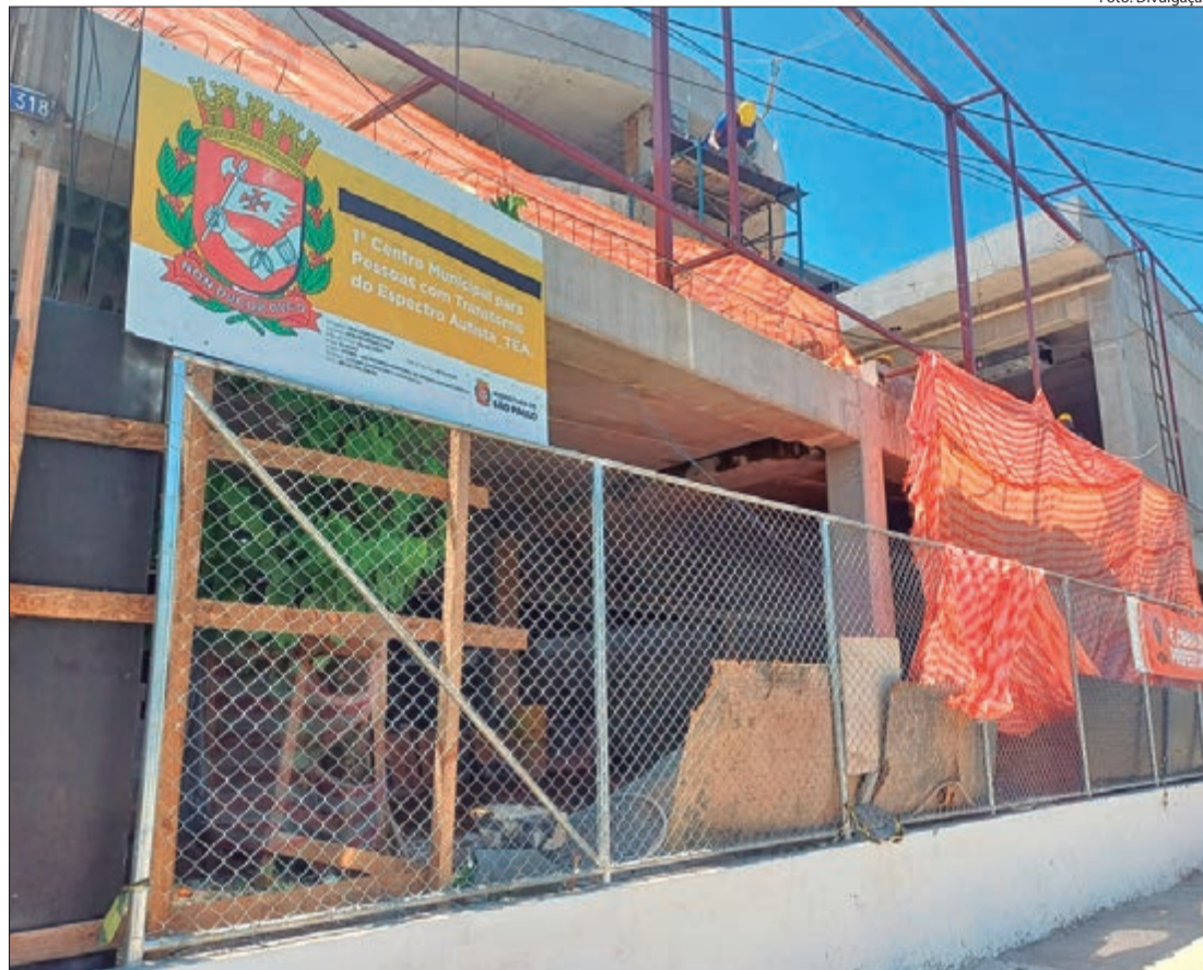
Obras do 1º Centro Municipal para Pessoas com Espectro Autista seguem aceleradas na Avenida Santos Dumont, 1.318
