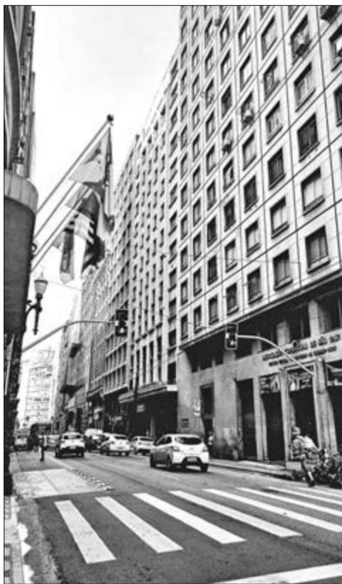
Fachada da Associação Comercial de São Paulo no centro de São Paulo, em foto preto e branco
